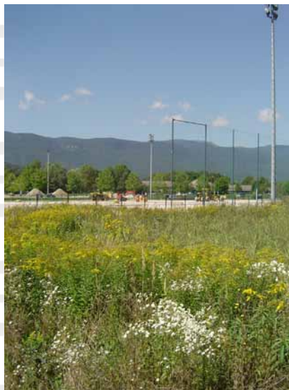
Bassins de rétention infiltration
