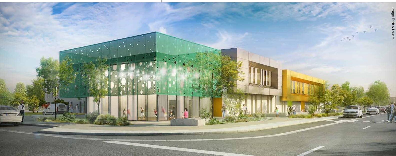
Vue depuis l'arrivée principale
